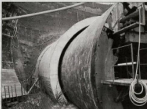
Vorgezogener Gewölbeschleppwagen nach Herstellung von Block 2
