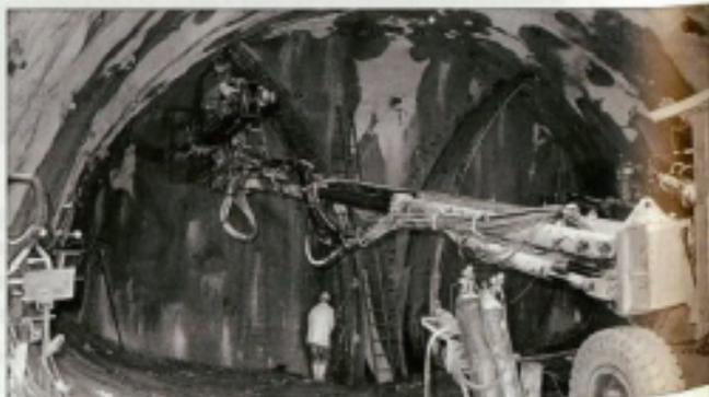
Das Gebirge um den Ausbruchquerschnitt zeigte eine hohe Injektionsgutaufnahme. Insgesamt wurden auf der etwa 33 m langen Ulmenstollenstrecke rund 350 Tonnen Zement als Suspension, teilweise ohne nennenswerten Druckanstieg, eingepreßt.
